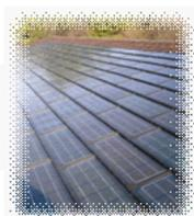
Astelas em Placas Solares DOW™ **POWERHOUSE™** são um exemplo. Indicadas como uma das “50 Melhores Invenções de 2009” pela revista *TIME*, essas telhas em placas fotovoltaicas permitem um maior aproveitamento da energia solar em casas. Elas se diferenciam por se integrarem ao telhado de telhas asfálticas tradicionais, que representa
