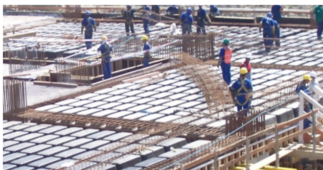
Figura 3 – Processo de Construção com Formas ATEX Fonte: ATEX (2012)
